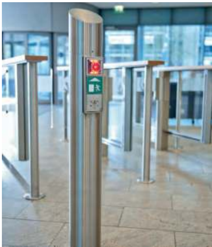
Стойка и картоприемник с терминалом эвакуационного выхода
