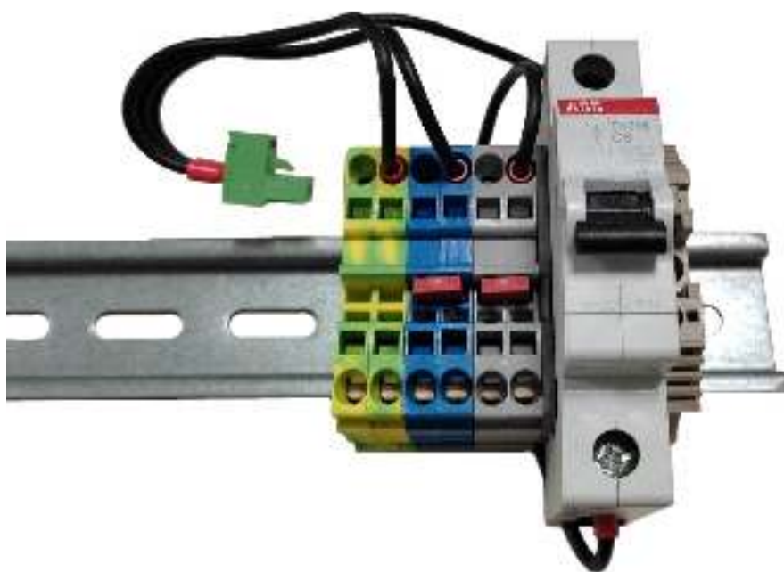
Рисунок 3.9 – Автоматический выключатель и клеммы
